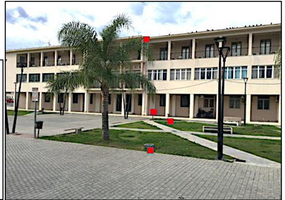
Σχήμα 2. Σχηματική διάταξη δικτύου σεισμομέτρων για τη μελέτη της αλληλεπίδρασης εδάφους-κατασκευής (αριστερά) και η υλοποίησή της στο κτίριο της Περιφερειακής Ενότητας Κεφαλονιάς & Ιθάκης στο Αργοστόλι.
